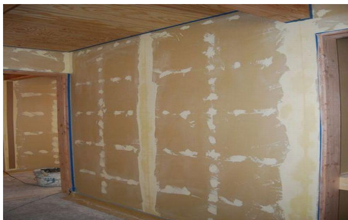
ジョイント処理完了
