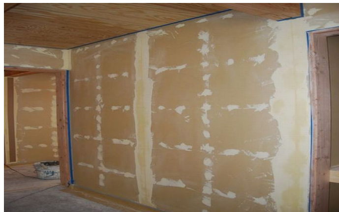
ジョイント処理完了
