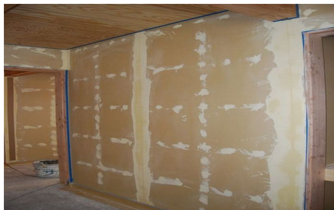
ジョイント処理完了
